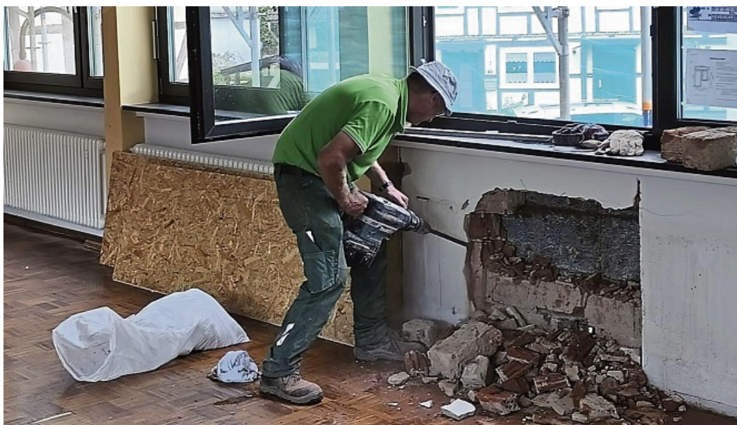
Durchbruch: Ein Handwerker stemmt im Saal des Adorfer Dorfgemeinschaftshauses die Außenwand auf. Dort soll ein zweiter Fluchtweg geschaffen werden. FOTO PR
