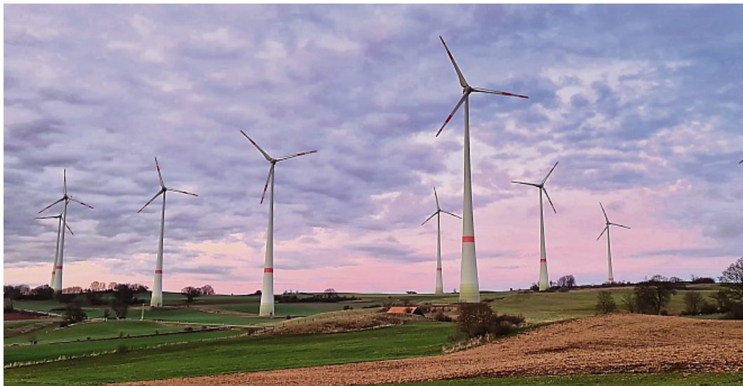
Windkraftanlagen in der Gemeinde Diemelsee: Eine von der Bundesnetzagentur verhängte Veränderungssperre blockiert ein Repowering-Projekt.
